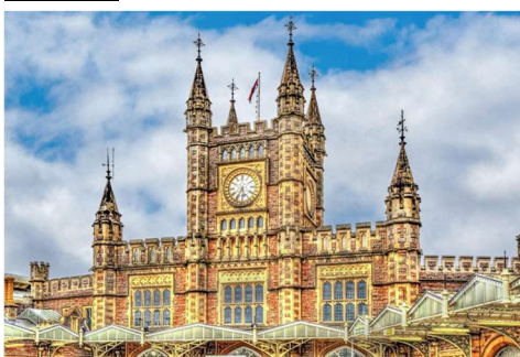
Der Eingang zum Bahnhof von Bristol
